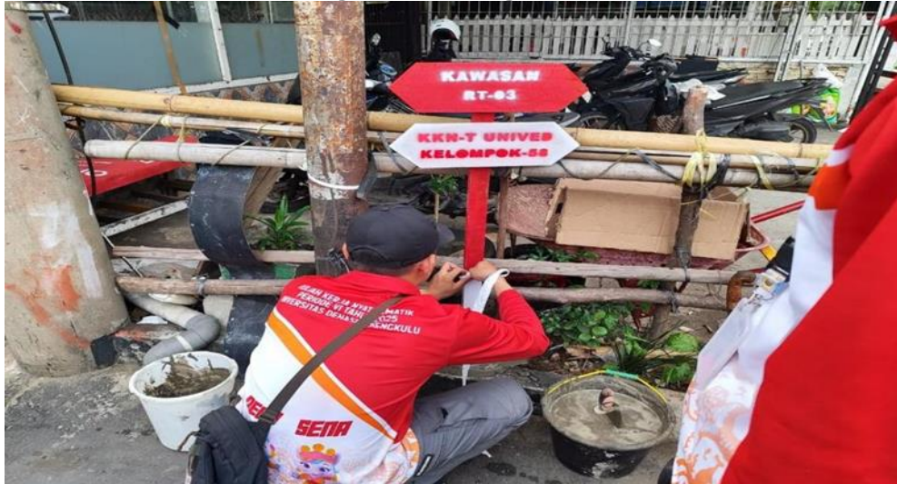
Gambar 1. Pengecoran Plang Pembatas Wilayah
